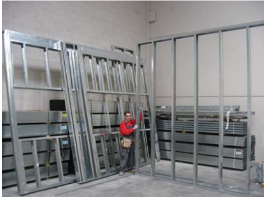
Posibilidad de premontaje de paneles en taller
