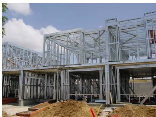
Estructura metálica ligera y envolvente exterior con paneles hidrófugos
