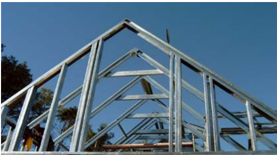
Cubiertas ligeras, tipo “buhardilla habitable” y tipo “a dos aguas”
