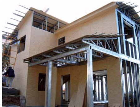
Ejemplos de cubiertas realizadas mediante cerchas de acero ligero
