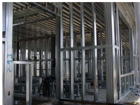
Elementos principales de pared y ejemplo de pared del sistema "Steel Framing"
