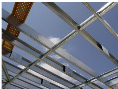
Ejemplos de cubiertas realizadas mediante vigas de acero ligero (cubiertas planas y buhardillas)
