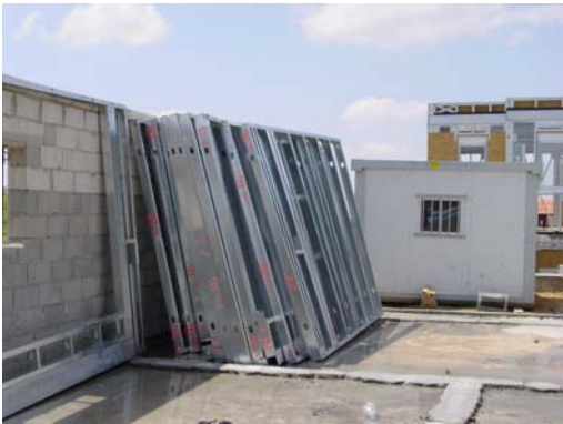
Posibilidad de premontaje de paneles en taller
