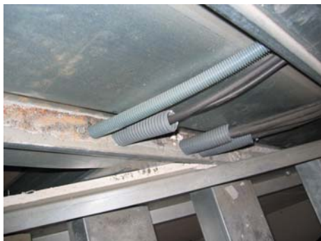
Paso de instalaciones y mecanismos integrados en el interior de las paredes
