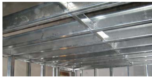
Ejemplos de forjados “en seco”, realizados con emparrillado de vigas de acero ligero
