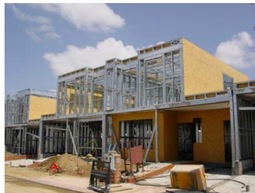
Estructura metálica ligera y envolvente exterior con paneles hidrófugos
