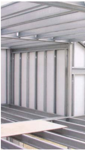
Ejemplos de forjados “en seco”, realizados con emparrillado de vigas de acero ligero
