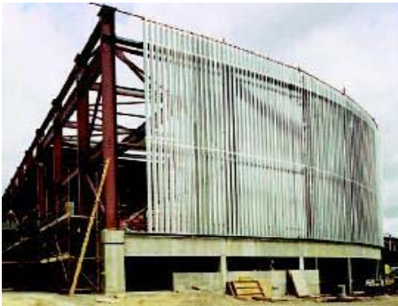
Cerramientos industriales de gran altura
