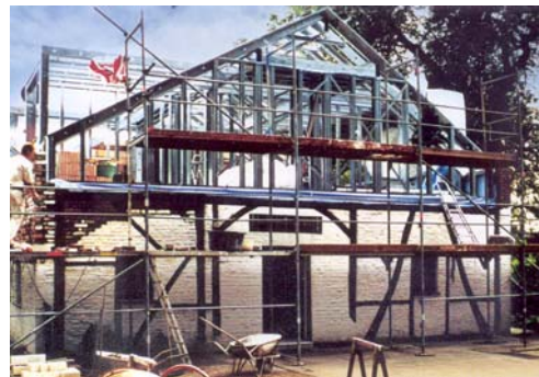
Ampliaciones en altura (remontas)
