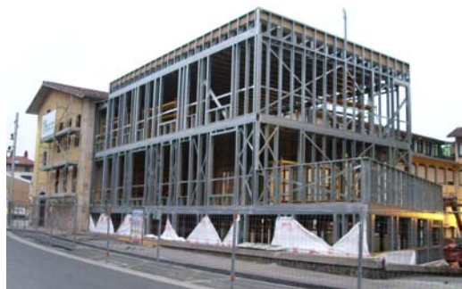
Estructura ligera para una edificación para un colegio
